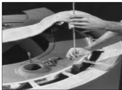
Figura 44. Limpieza ducto de fuego.
