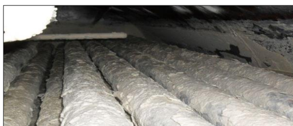
Figura 8: Incrustaciones en calderos
