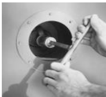
Figura 38. Desmontaje de Conjunto Hand hole
