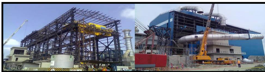
Figura 3. Hangar de ANDEC
