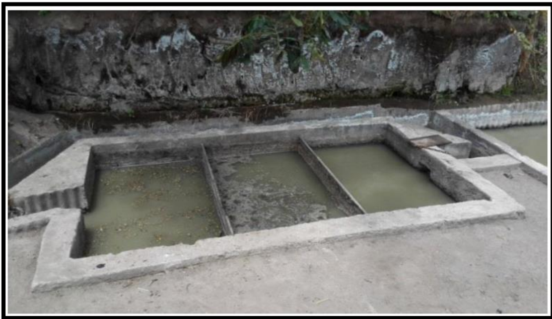
Figura 10 Desarenador.
