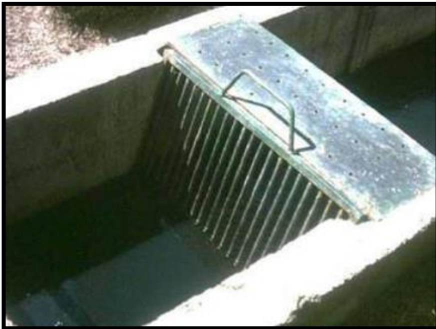
Figura 2 Rejilla de desbaste. Fuente: (Ramalho, 2003)
