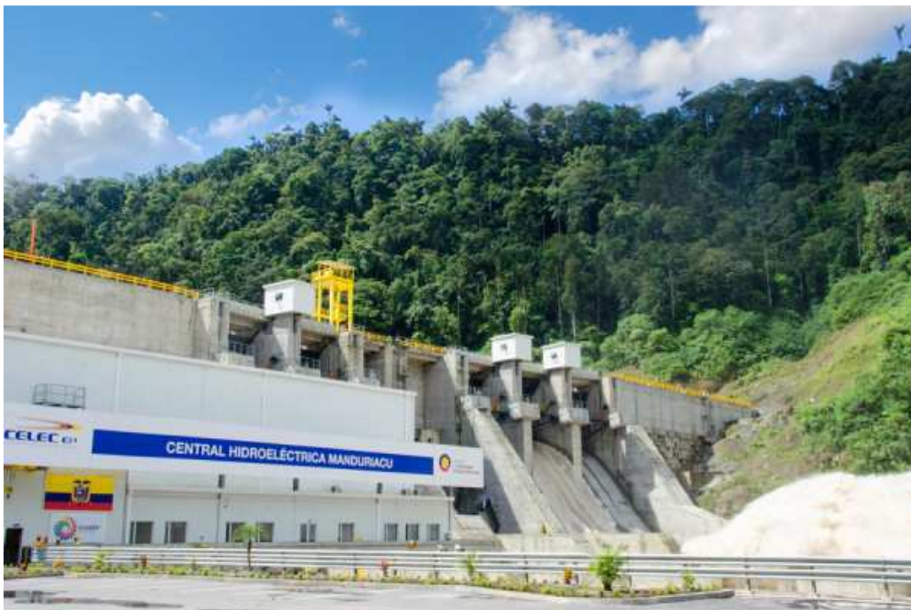
Figura 33. Central hidroeléctrica Mandariacu
