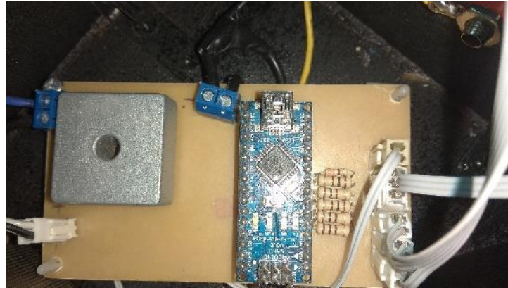
Figura 104. Placa electrónica de la estación de carga.
