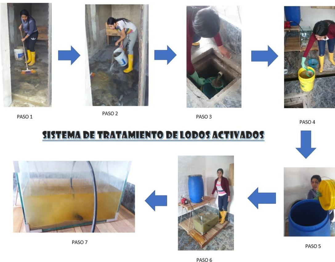
**Figura 8** Proceso para la implementación del Sistema de Tratamiento de Lodos Activados
