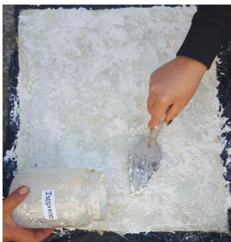
Figura 72. Colocación del isopreno en la estera de fibra de vidrio
