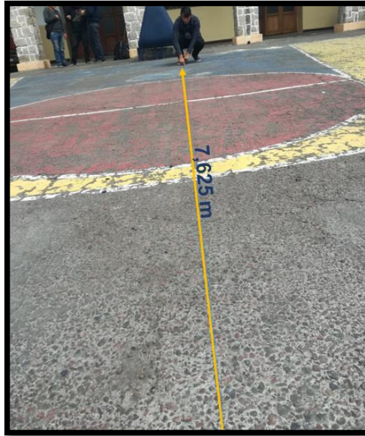
Figura 83. Trazado de circunferencia en el piso
