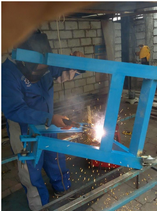
Figura 37. Terminación de la estructura.
