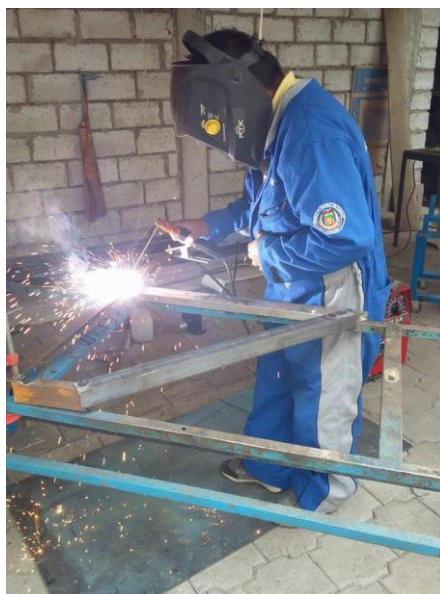
Figura 36. Construcción de la estructura.
