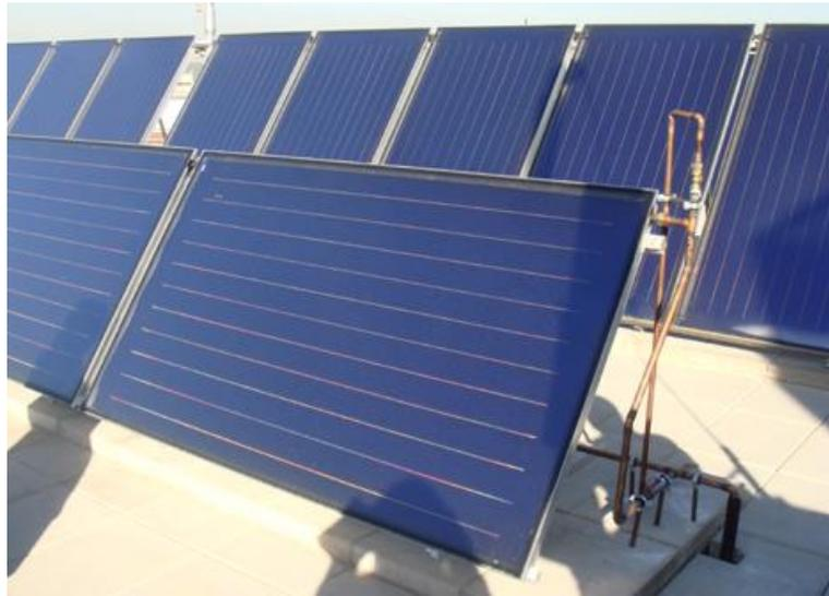
**Figura 2:** Calentador solar plano no protegido
