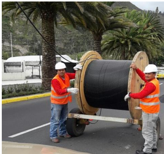
Figura 68 Forma correcta de desenrollar el cable.
