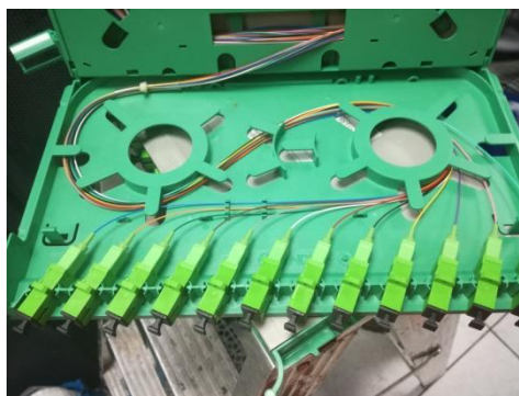
Figura 77 Bandeja de ODF con respectivos pigtails
