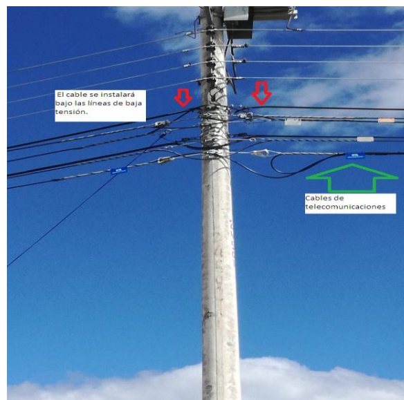
Figura 39 Instalación de cable de fibra óptica en postes
