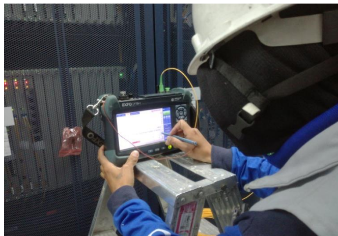
Figura 80 Realización de pruebas con OTDR.
