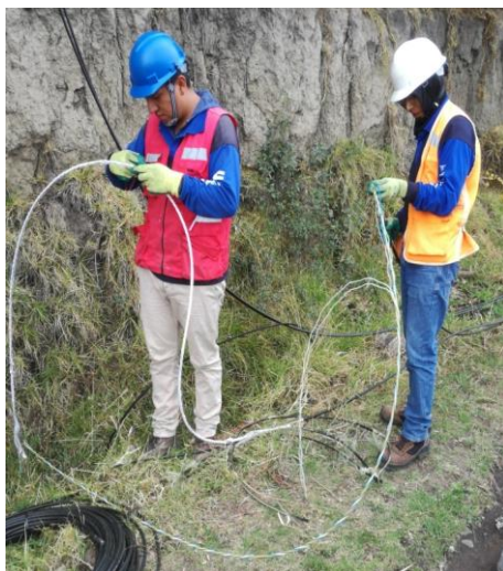
Figura 73 Preparación de la fibra óptica
