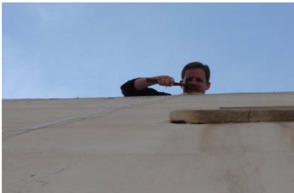
Figura 4.55. Instalación de equipos
