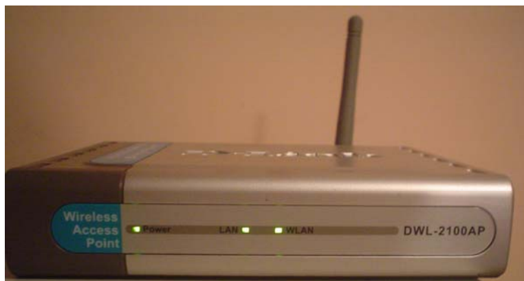
Figura 4.60. Status del Access Point instalado.
