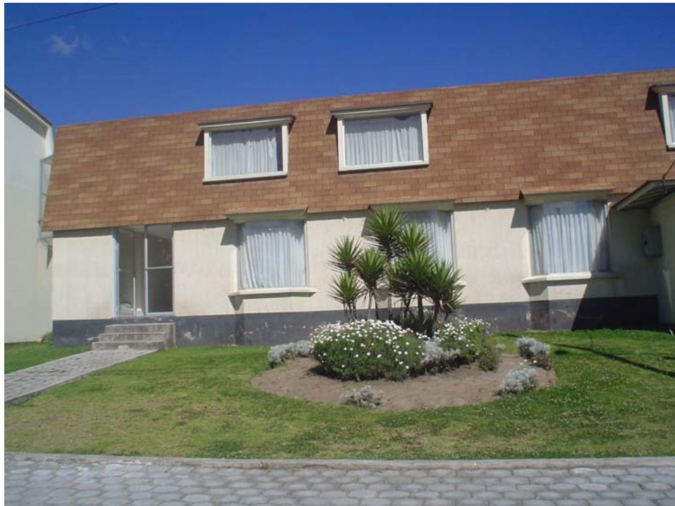
Figura 2.9. Casa Comunal Sector C
