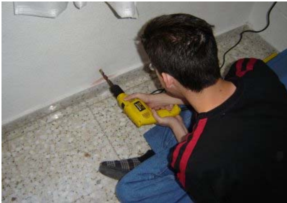
Figura 4.54. Tendido de cable
