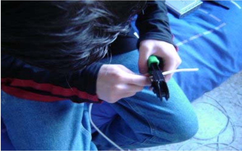
Figura 4.53. Ponchado de cable
