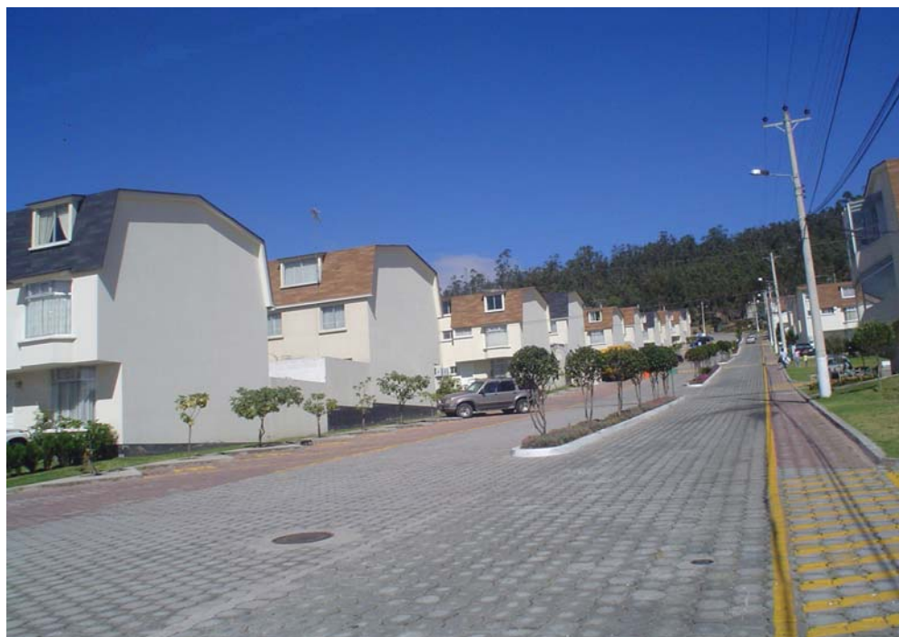
Figura 2.6. Nivel del Conj. Vista hacia la entrada
