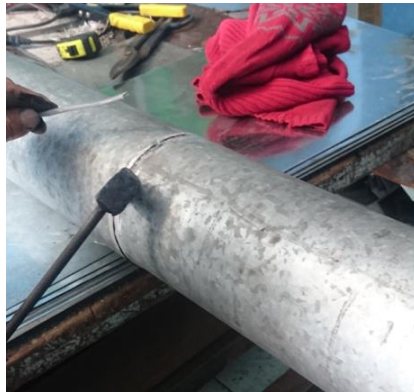
Figura 30 Soldadura del ducto
