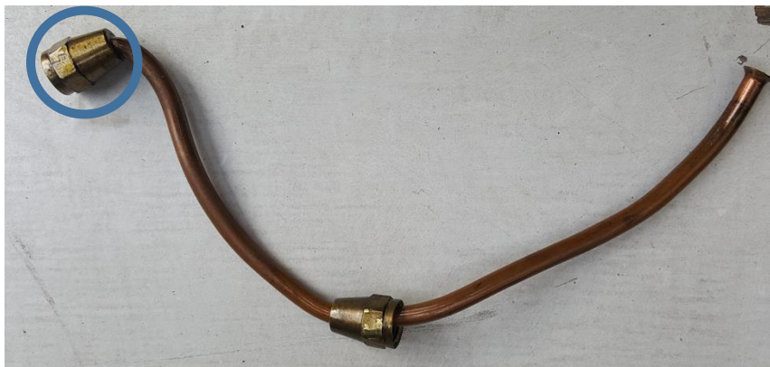
Figura 52 Tubería de combustible.
