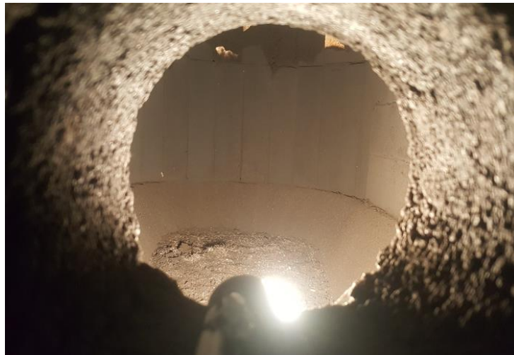
Figura 55 Inspección del ladrillo refractario.
