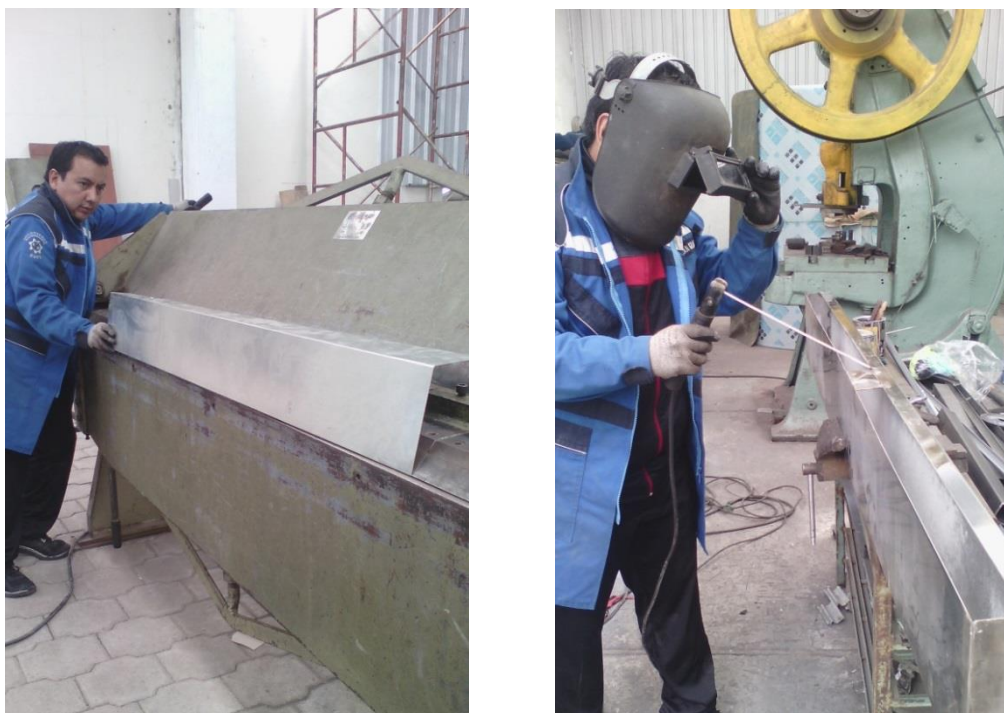
Figura 66. Construcción y montaje de guías
