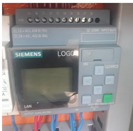
Figura 82. Funcionamiento del PLC
