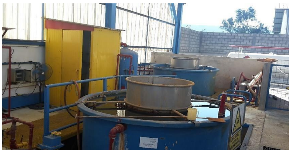
Figura 22. Estado Inicial “PTARI”
