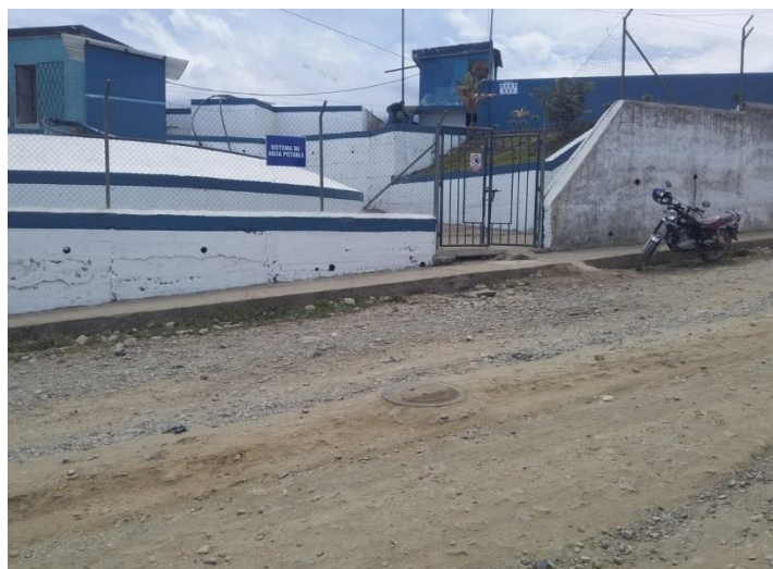
Figura 11. Planta de Tratamiento de Agua Potable
