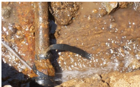
Figura 15. Tubería de hierro, calle Sucre
