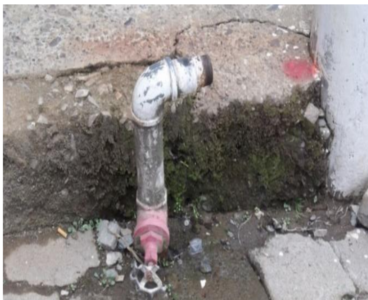
Figura 17. Hidrante deteriorado
