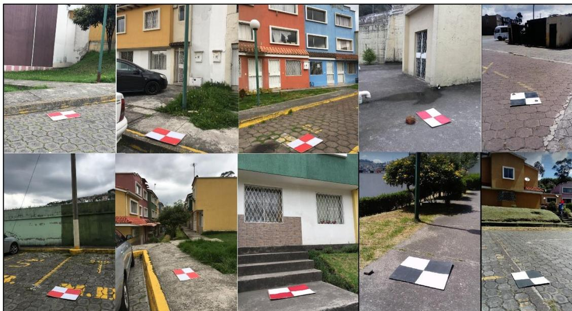
**Figura 32.** Posicionamiento de marcas de control terrestre.
