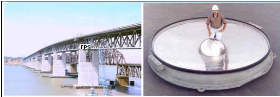
Figura 2.9: Puente Benicia-Martinez, California, instalado con aisladores F.P.S
