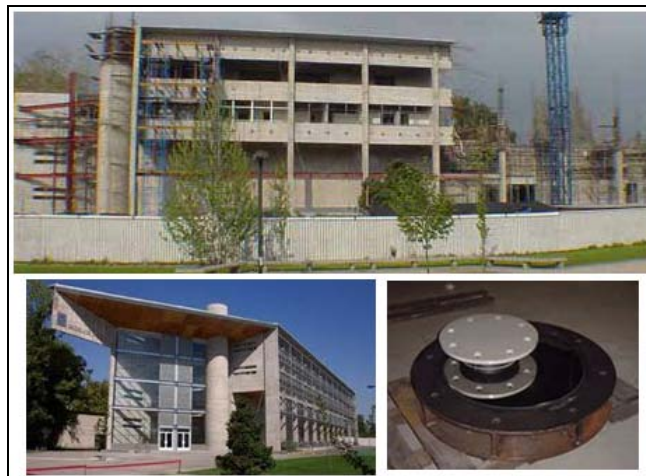
Figura 2.14: Edificio San Agustín, Apoyo deslizante
