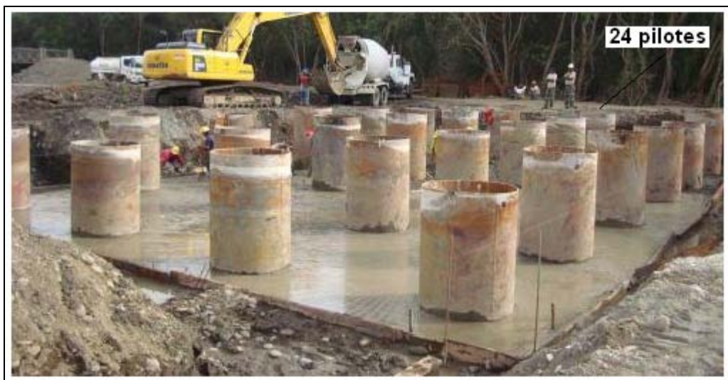
Figura 2.22: Pilotaje del estribo tipo cajón. 4
