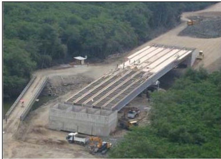
Figura 2.16: Puente Norte 1 vista aérea
