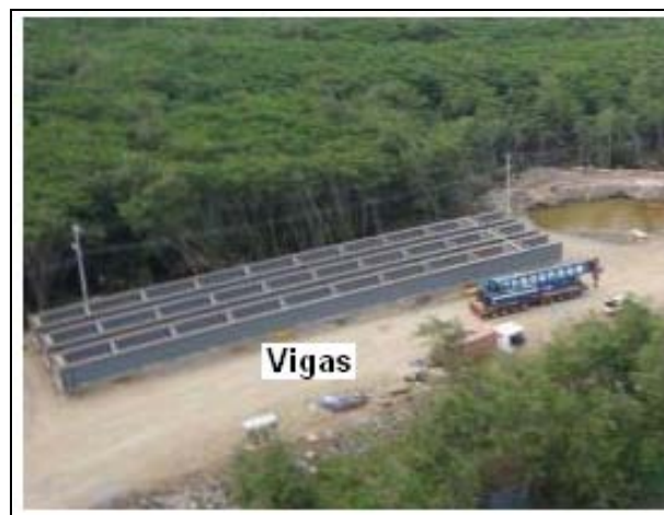
Figura 2.18: Vista aérea de vigas de acero 2
