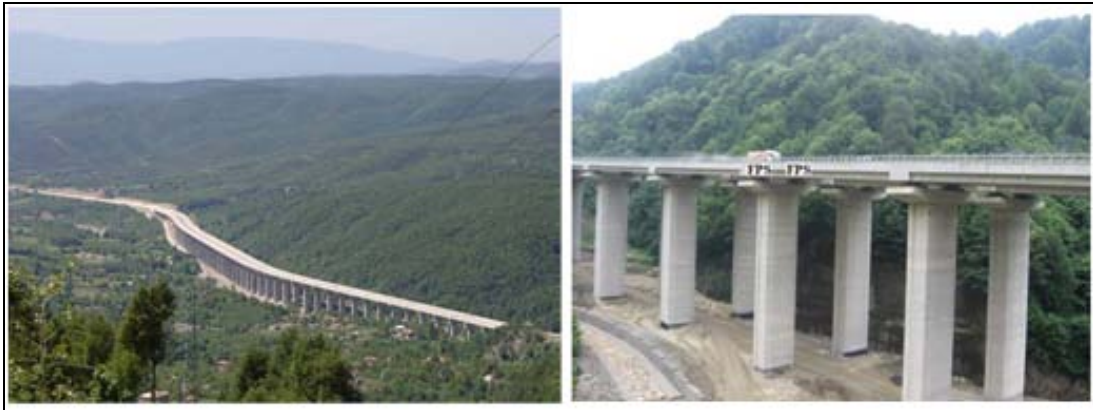
Figura 2.10: Viaducto de Bolu, Turquía, instalado con aisladores F.P.S
