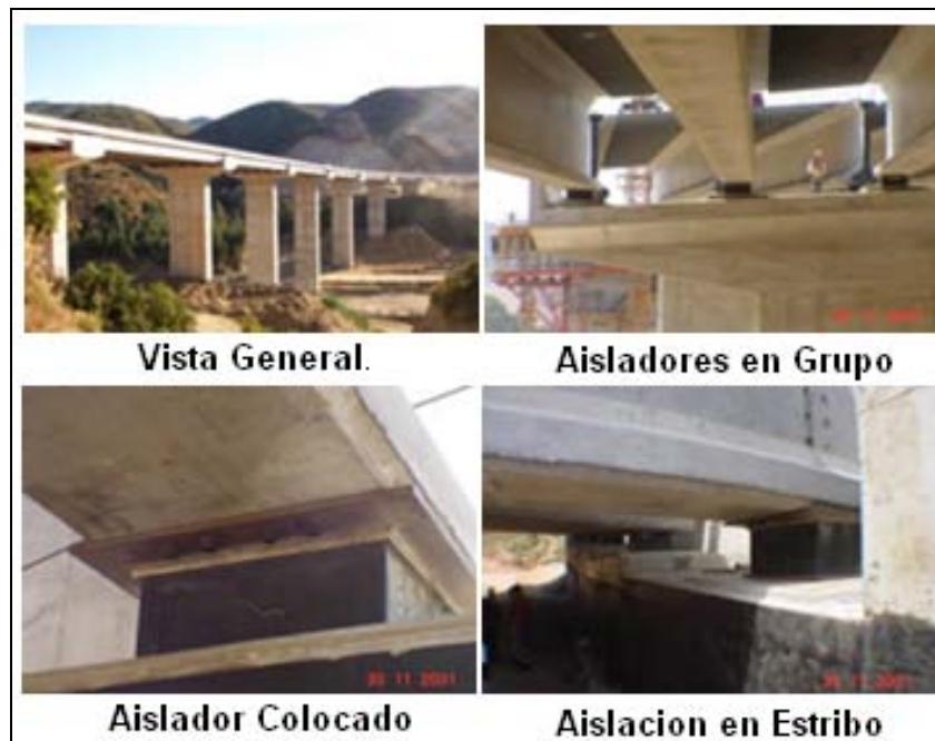
Figura 2.7: Puente Marga - Marga Troncal Sur, Chile
