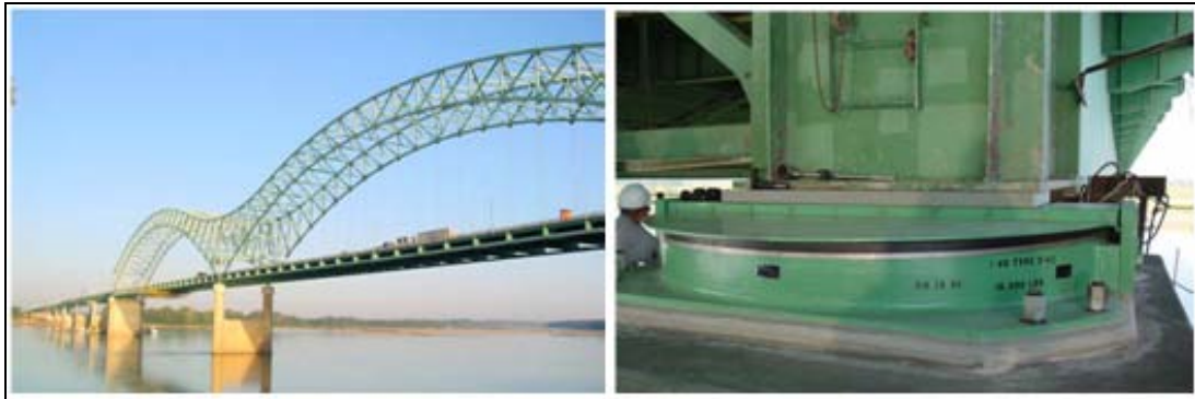
Figura 2.11: Puente I-40 ubicado sobre el río Mississippi, instalado con aisladores F.P.S
