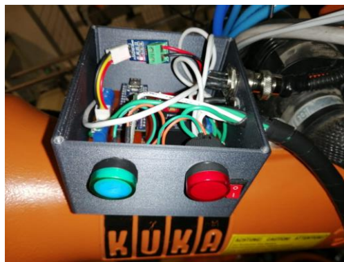
Figura 101. Montaje del circuito de control de velocidad
