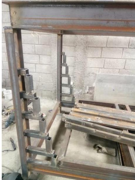
*Figura 165* Ubicación de soportes para el sistema de rieles.
