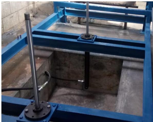
*Figura 178* Instalación de los cilindros hidráulicos
