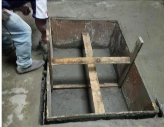
*Figura 175* Realización de la fosa para cilindros hidráulicos.
