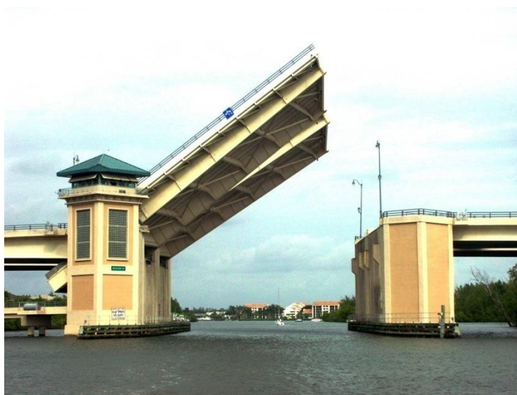
Figura 47. Puente Basculante viga I
