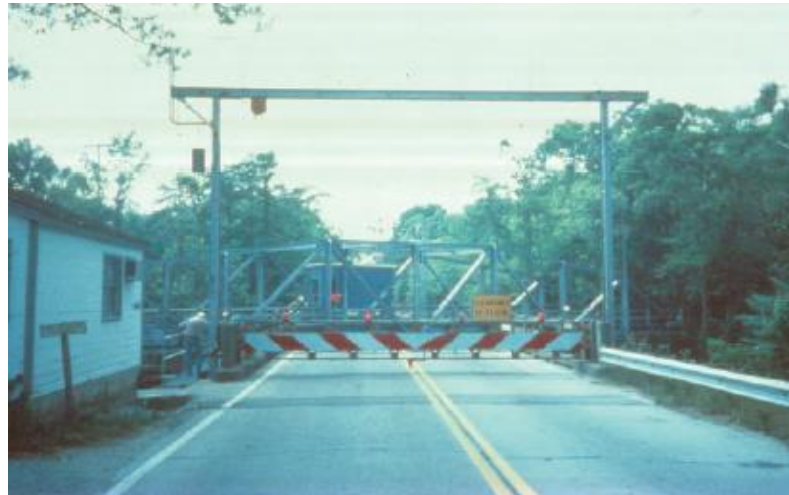
Figura 14. Barreras de Tráfico
