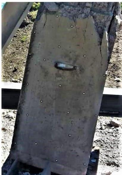
**Figura 37.** Puntos de control para escaneo.
