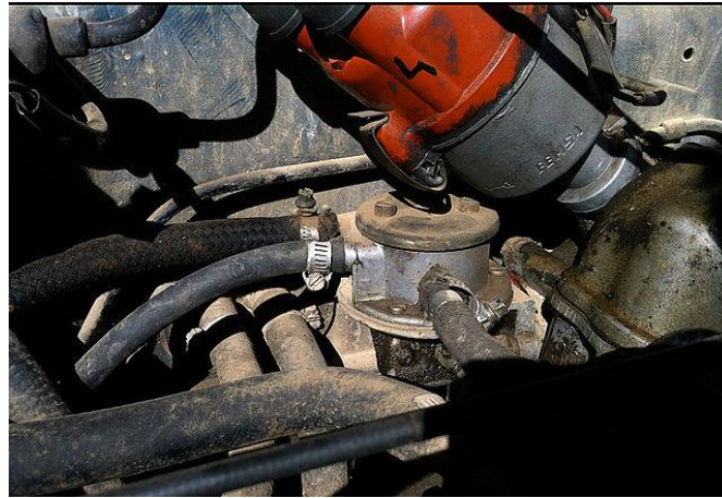
Figura 28. Prueba de Caudal Bomba de Combustible
