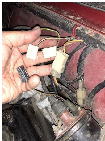
Figura 34. Punto de toma de señal
