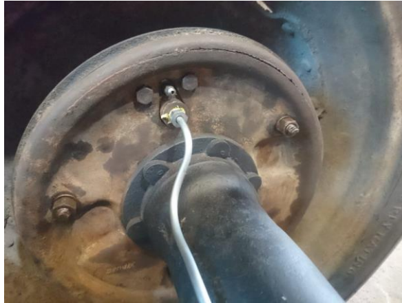
Figura 69. Instalación de tubería de freno finalizada, en un tambor posterior
