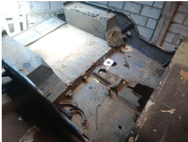
Figura 87. Restauración de la cabina
