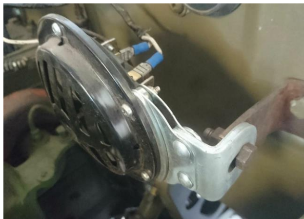
Figura 79. Instalación del claxon
