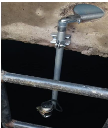
Figura 51. Sujeción del soporte del sensor TSPC-15S-485
