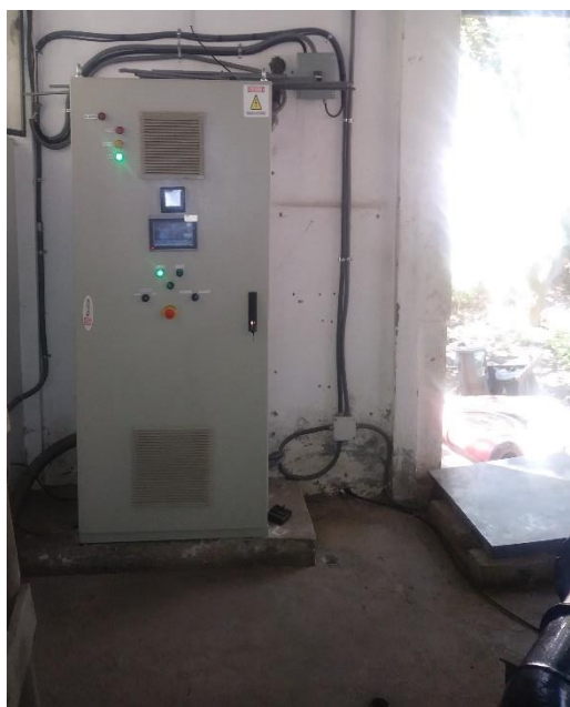
Figura 94. Puesta en marcha del nuevo tablero de la estación.
