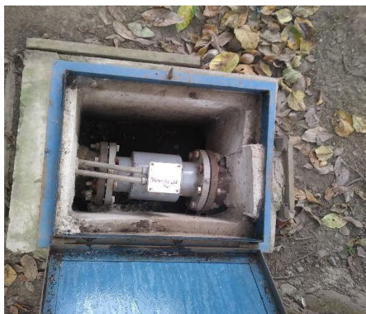
Figura 77. Elemento primario de medida del Badger meter M2000.
