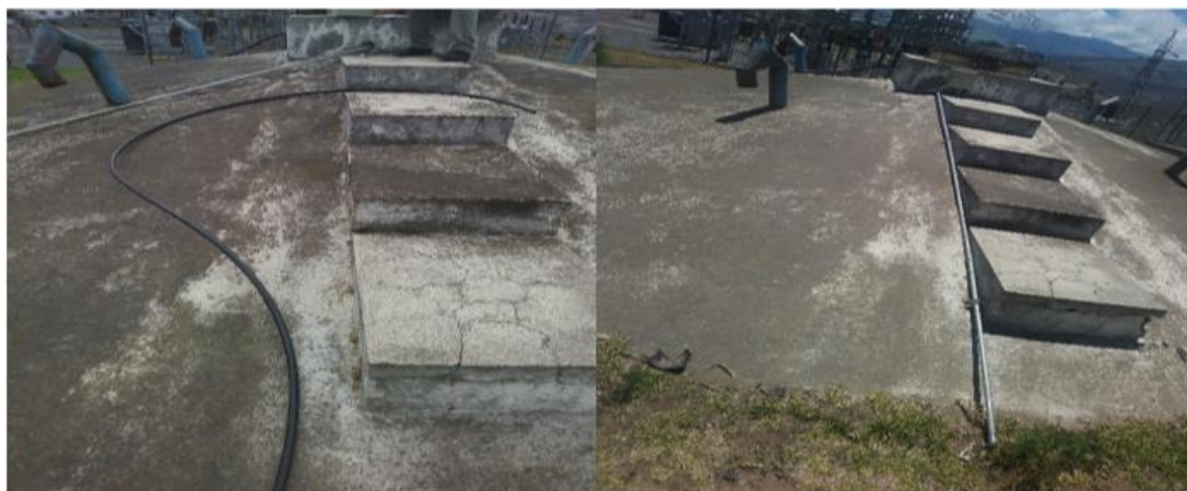
Figura 53. Instalación de la tubería industrial por fuera del tanque.
