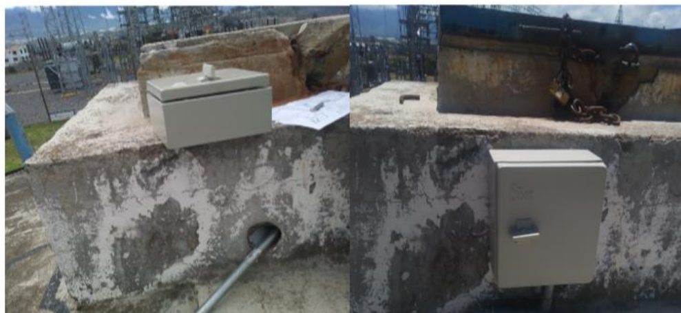
Figura 52. Instalación caja de paso metálica Sbox.
