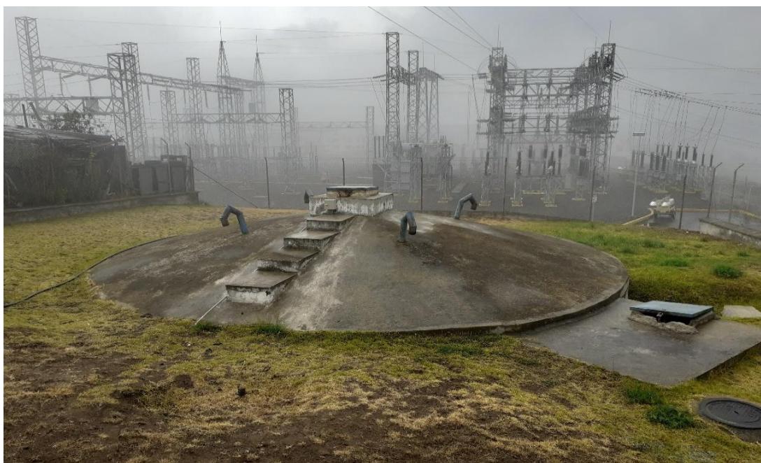
Figura 48. Tanque de almacenamiento La Península
