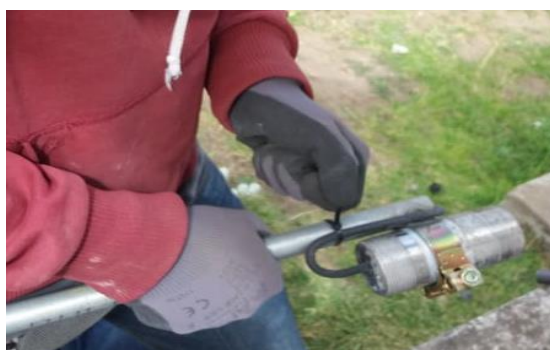
Figura 50. Instalación del soporte del sensor TSPC-15S-485
