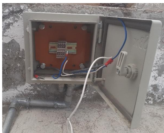
Figura 63. Instalación del doble fondo, riel DIN y borneras en caja de paso.
