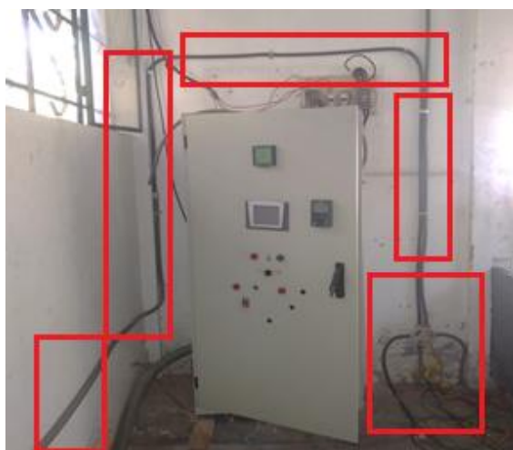
Figura 85. Reubicación de las tuberías eléctricas instaladas en la estación.
