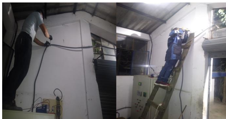
Figura 84. Ajuste de la tubería funda sellada BX de 1/2" con la pared.
