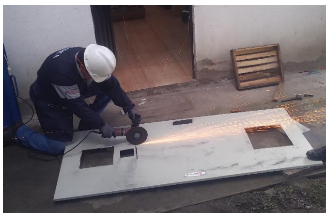
Figura 89. Corte de la puerta del tablero de fuerza y control
