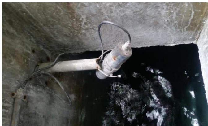
Figura 75. Sensor ultrasónico en deterioro.
