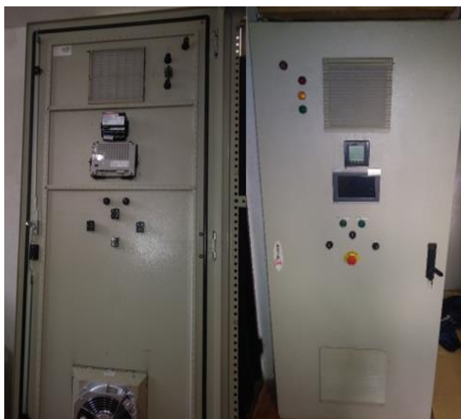
Figura 90. Instalación de los elementos en la puerta del tablero de fuerza y control.
