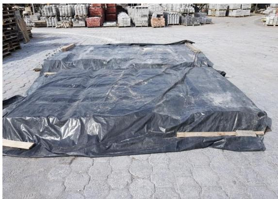
*Figura 69.* Los bloques después de curarlos se cubren con un plástico
