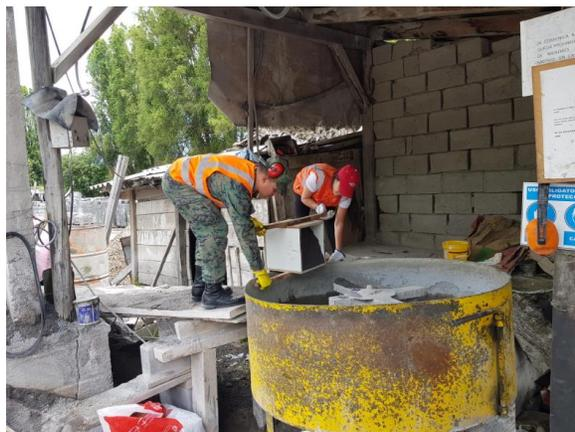
*Figura 56.* Estudiantes colocan los agregados en la mezcladora industrial
