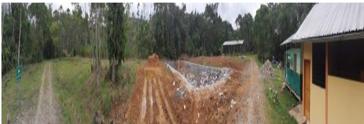
Figura 28. Vista panorámica del relleno sanitario del GAD Municipal del cantón Arajuno.
