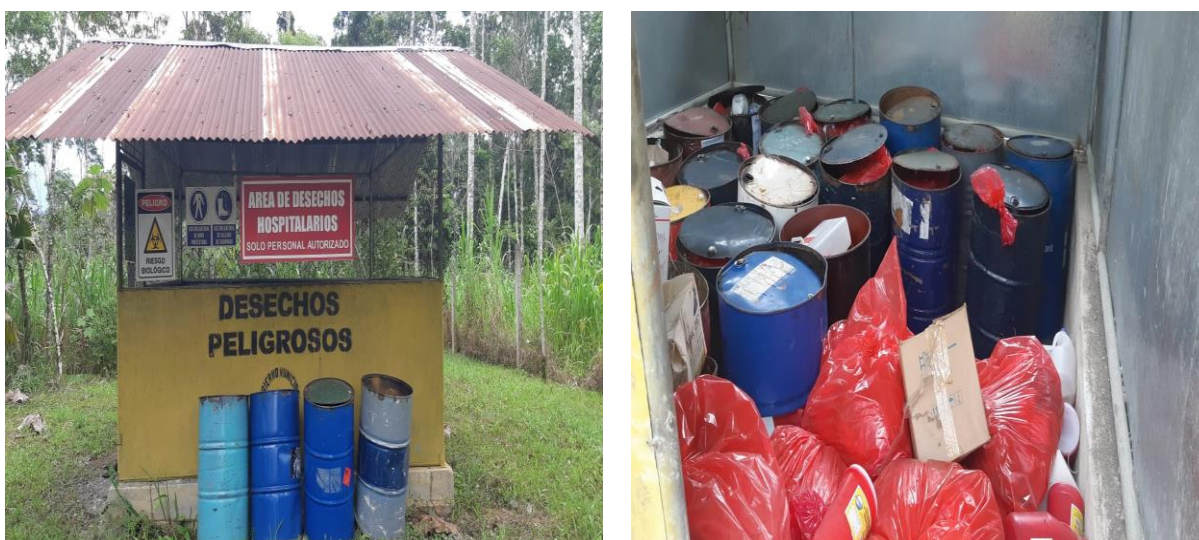
Figura 29. Infraestructura de disposición final de desechos sanitarios en el relleno sanitario del GAD
