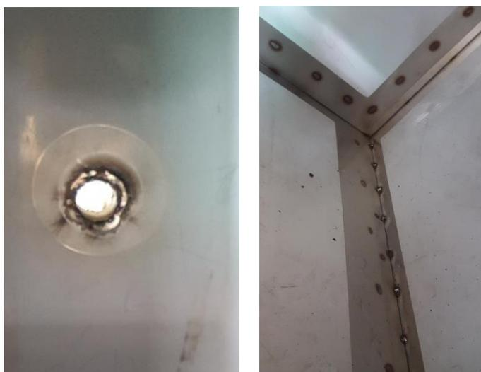
**Figura 107.** Unión de pared posterior con la estructura
