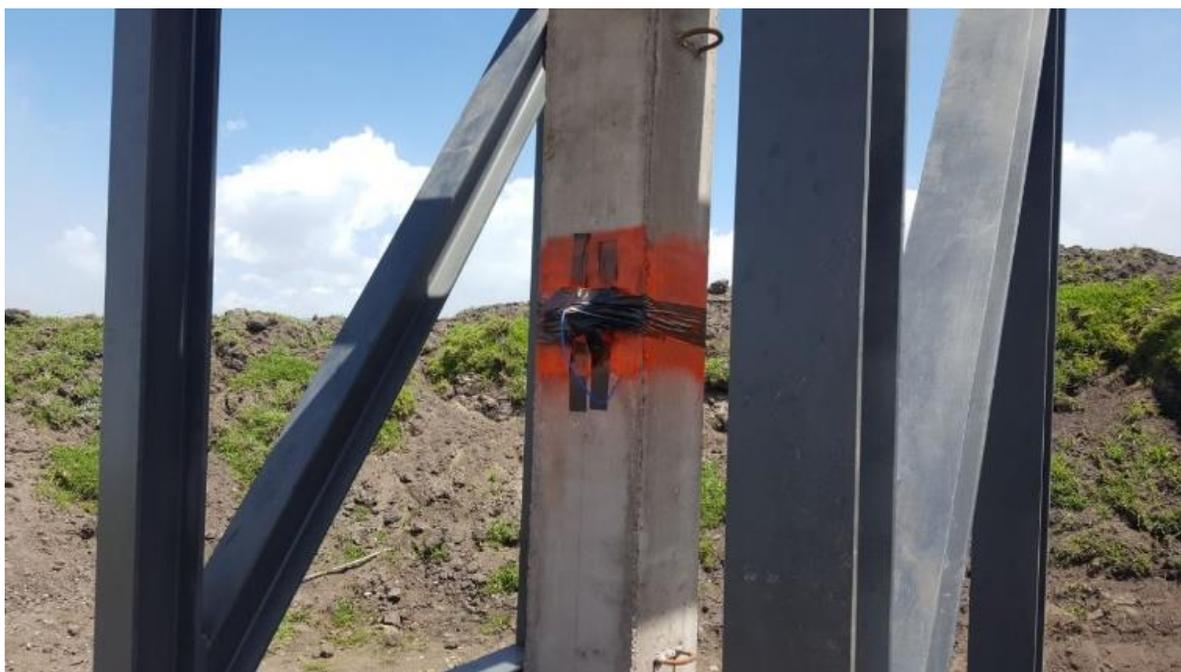
*Figura 39.* Colocación de carga explosiva
