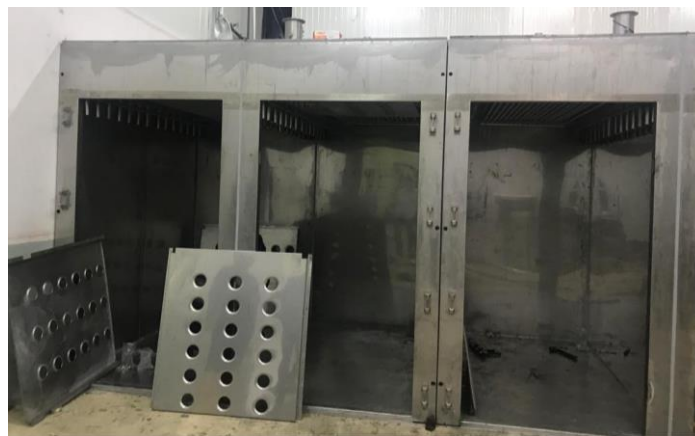
Estructura Inicial de Hornos
