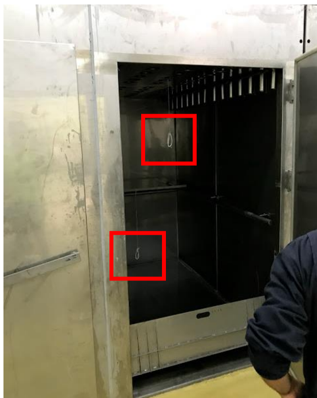
Ubicación de Cool-Tracks Dentro de los Hornos
