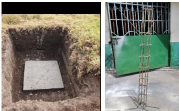
Fundición del Replantillo y Refuerzo de Acero
