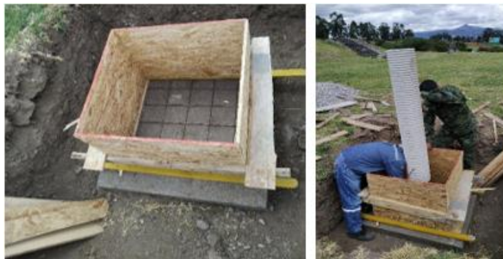
Encofrado y Colocación del Tubo PVC
