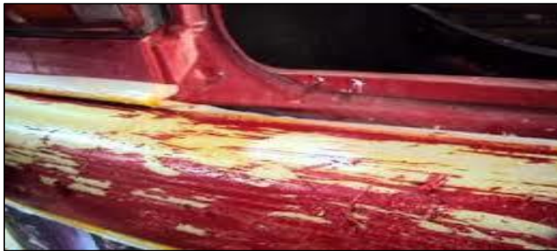
Figura 42. Espera de secado de pintura
