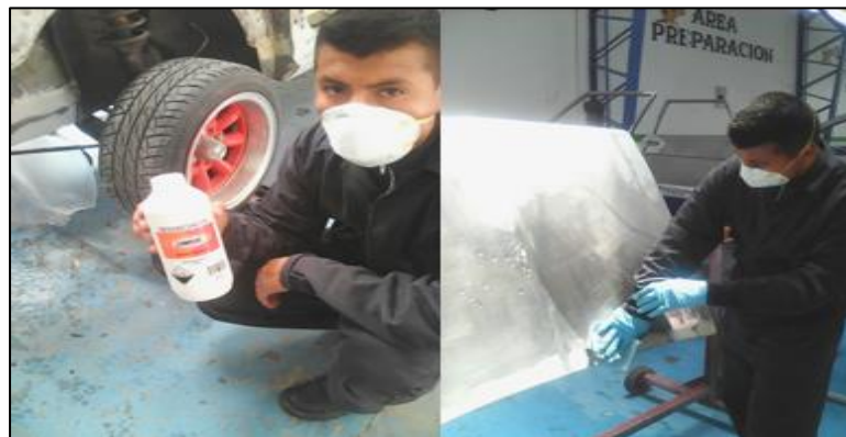
Figura 50. Aplicación del antioxidante
