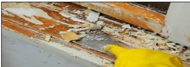
Figura 43. Retiro de pintura
