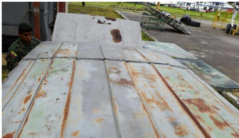
**Figura 26 Corrosión que existe en el techo**
