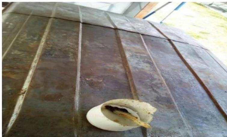
**Figura 32 Finalización del decapado de pintura**
