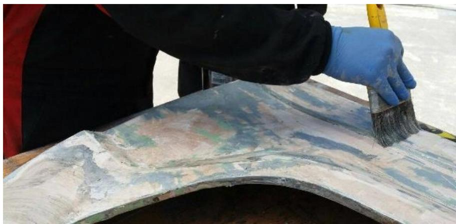
**Figura 30 Aplicación de removedor**
