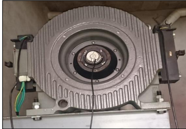
Figura 40 Máquina de tracción (motor)
