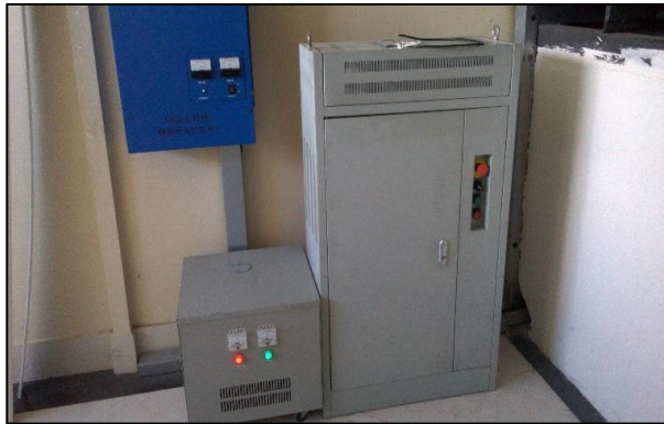
Figura 22 Sistema eléctrico del ascensor
