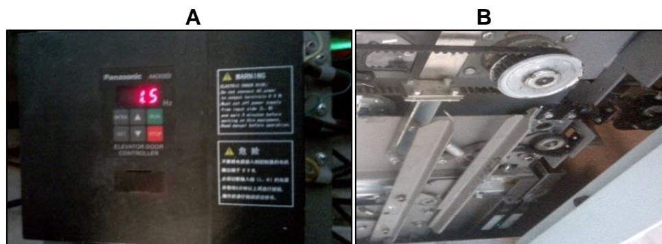
Figura 39 Controlador de la puerta (variador) y mecanismo
