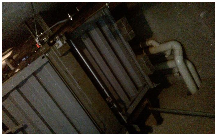
Figura 35 Control instalado en la cabina
