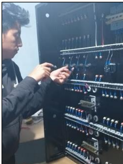
Figura 122. Ajustes finales del cableado
