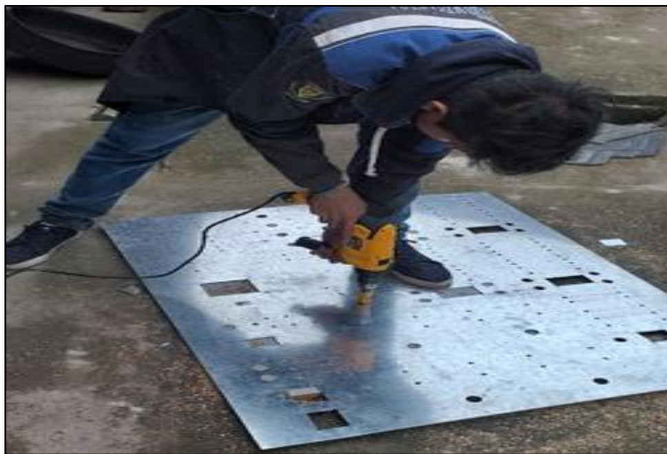
Figura 66. Perforación para los prensaestopas, pulsadores y luces piloto
