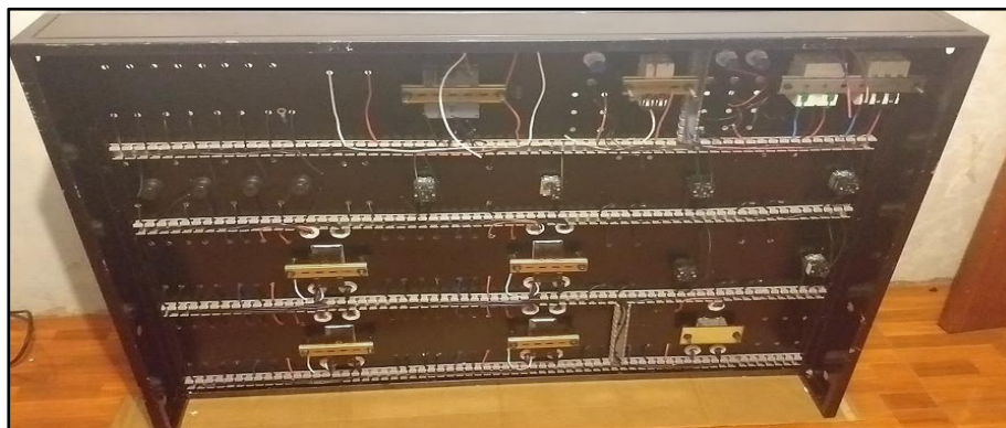
Figura 113. Tendido de cables finalizado
