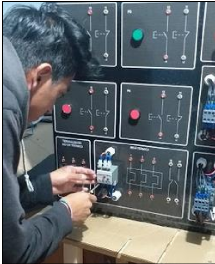
Figura 120. Conexión de cables en el relé térmico
