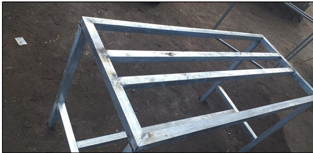
Figura 76. Estructura completamente soldada
