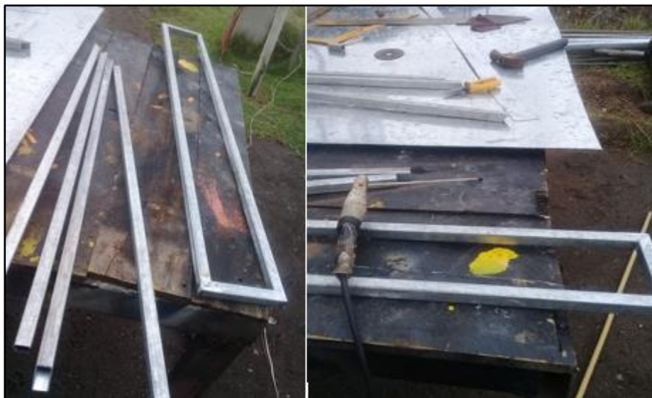
Figura 78. Proceso de corte y soldadura de tubos cuadrados
