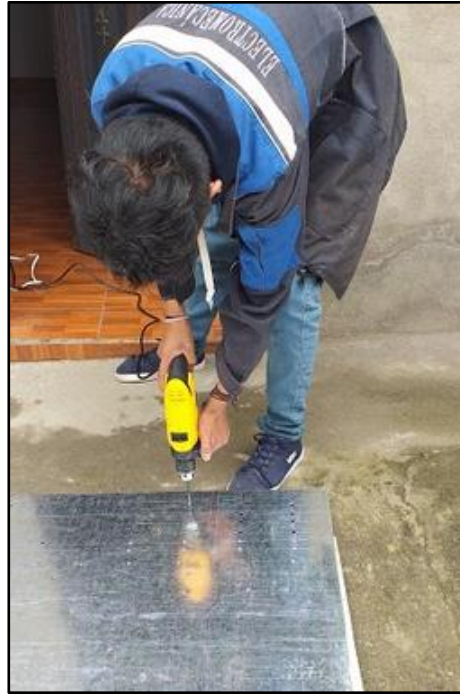
Figura 61. Proceso de perforación
