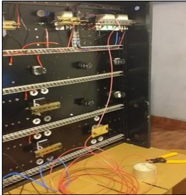
Figura 108. Tendido de cables
