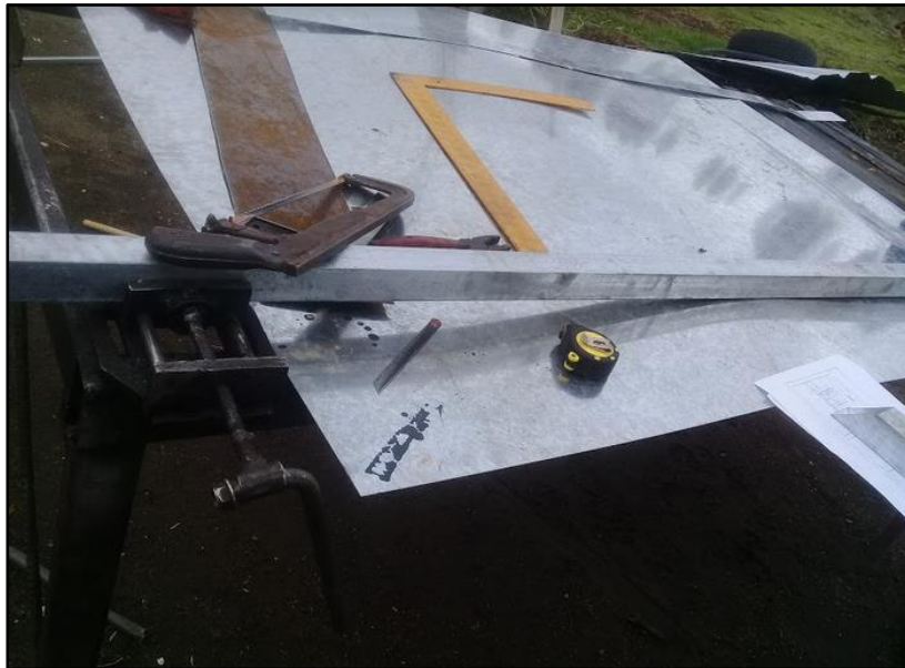
Figura 71. Corte de tubos cuadrados
