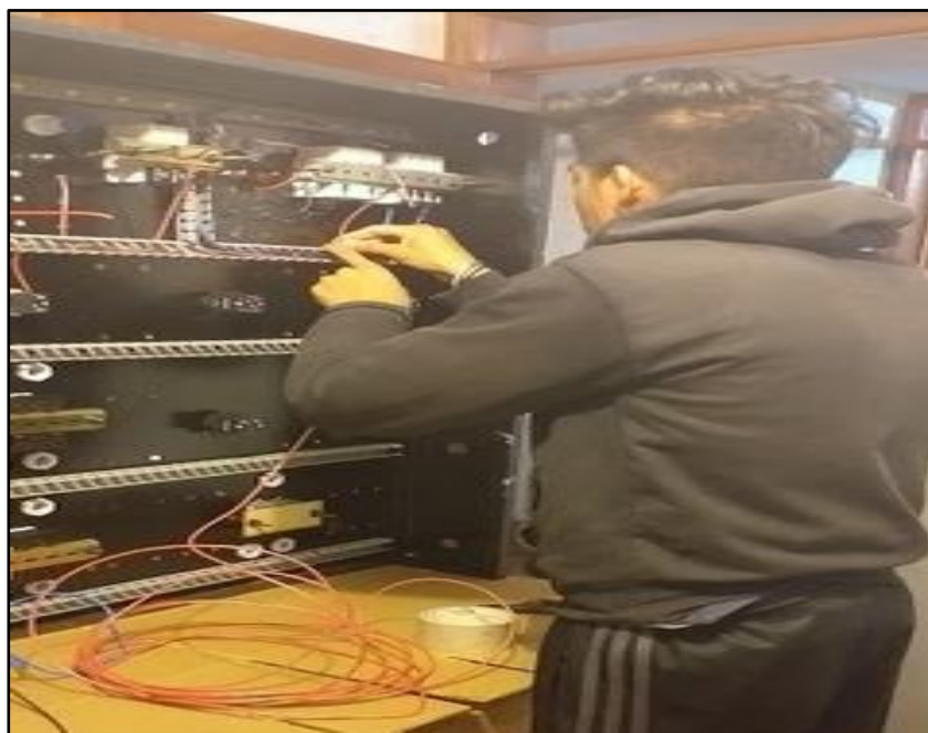
Figura 111. Breaker trifásico, monofásico y fusibles conectados
