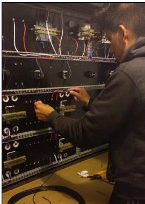
Figura 110. Peinado de conductores
