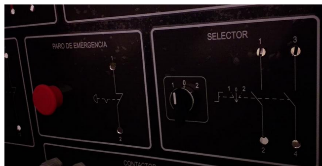
Figura 103. Paro de emergencia y selector
