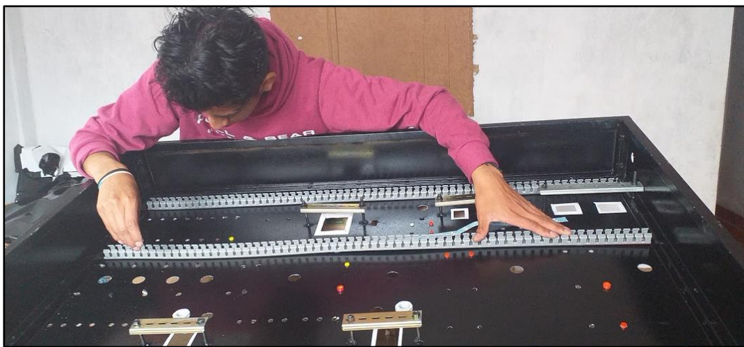
Figura 95. Montaje de canaletas ranuradas
