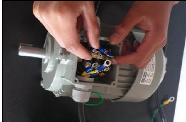
Figura 132. Conexión del motor trifásico
