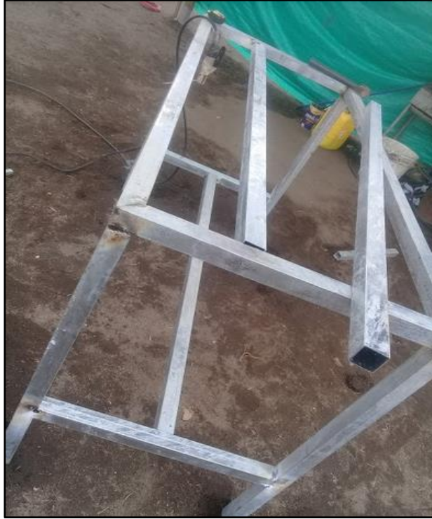
Figura 75. Centrado de tubos cuadrados
