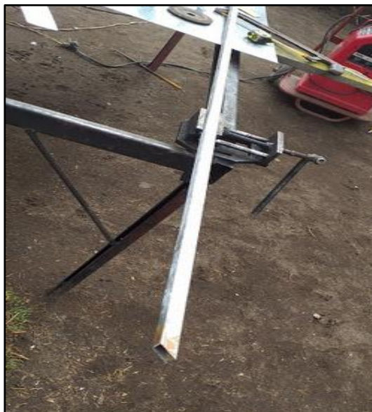
Figura 54. Corte de los tubos cuadrados.
