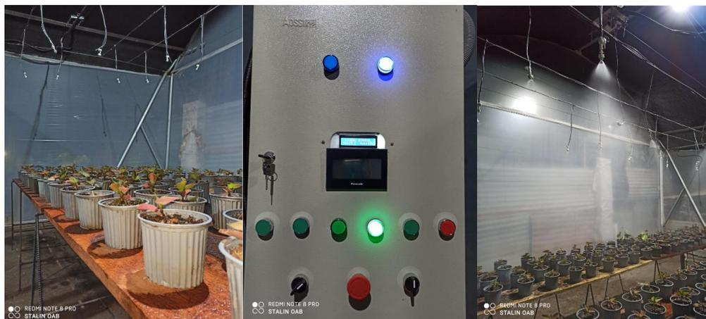
Nota: A: sistema de riego apagado, B: indicador del funcionamiento del sistema de riego, C: sistema de riego en funcionamiento.
