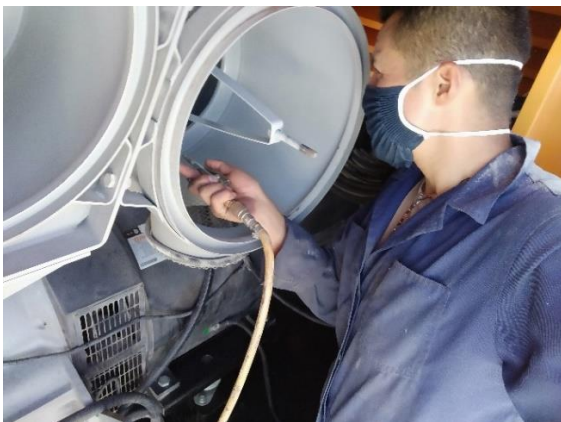
Depurador de aire
