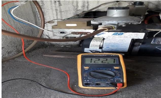
**Figura 27.** Conexión eléctrica del quemador.
