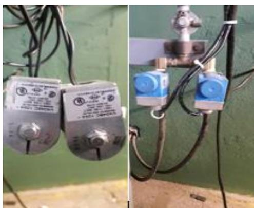
**Figura 18.** Reemplazo de electroválvulas.
