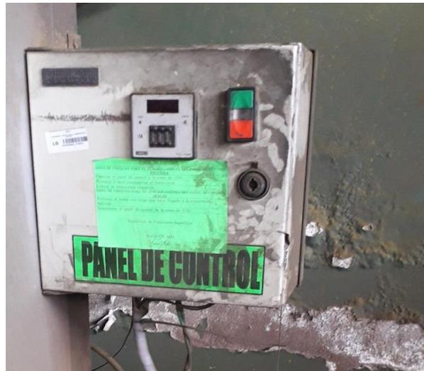
**Figura 13.** Gabinete en malas condiciones.
