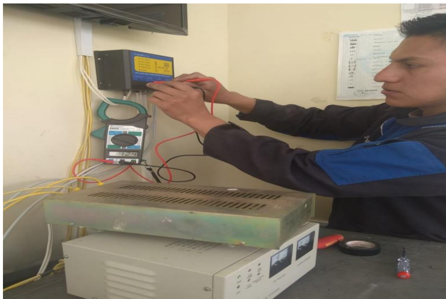
Figura 44. Comprobación de voltajes en las entradas y salidas
