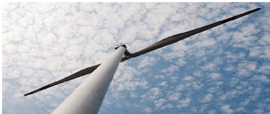
Figura 8. Parque eólico Towards 2000
