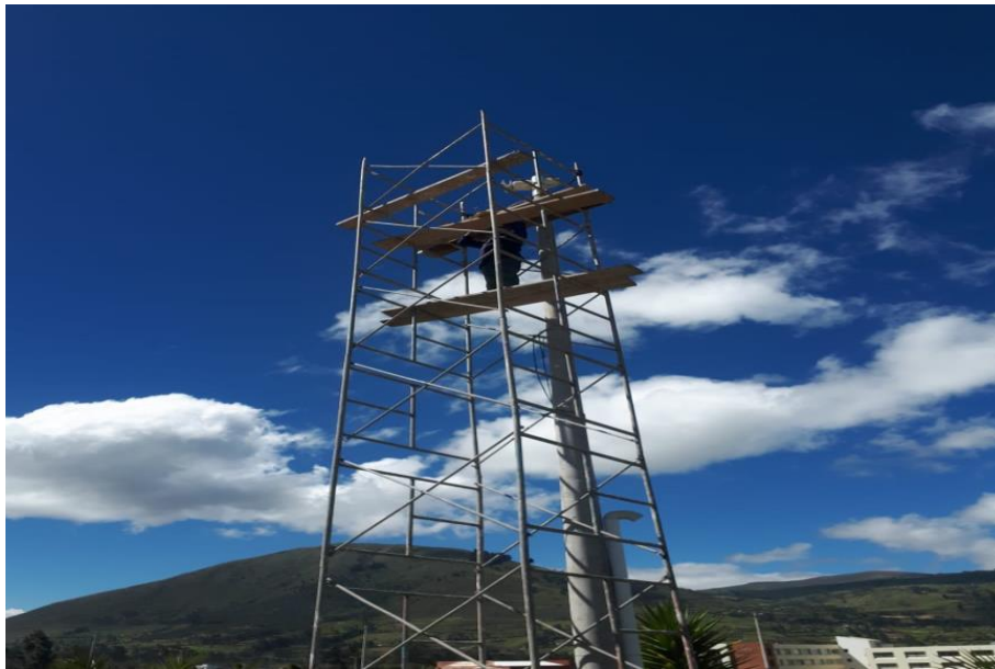
Figura 40. Instalación de turbina Exmork 500W
