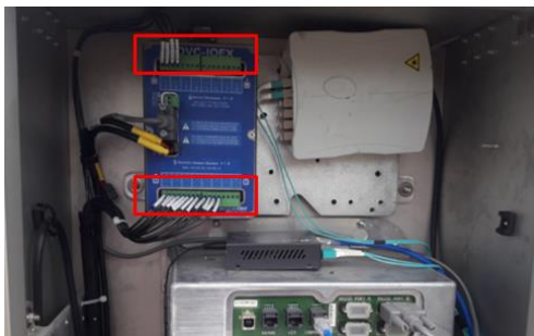
Figura 102 Borneras de tarjeta IOEX
