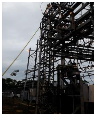
Figura 82. Cierre de bypass por pértiga
