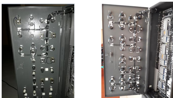
Figura 63 Alisado de cables de elementos de control
