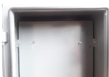
Figura 57 Doble fondo instalado
