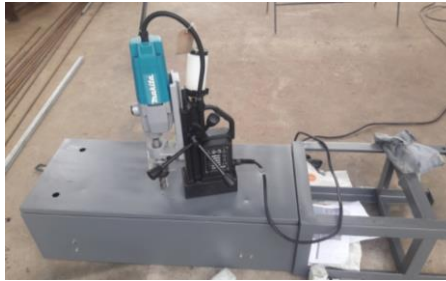
Figura 58 Perforación de tapa principal de tablero
