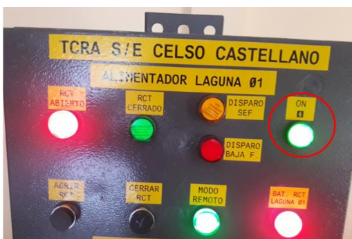
Figura 85 Energización y arranque de tablero TCRA
