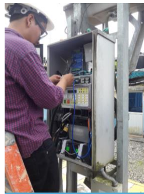
Figura 73 Tarjeta IOEX en RCT laguna 04
