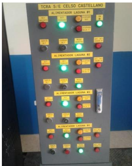
Figura 104 Inspección de estado de tablero TCRA
