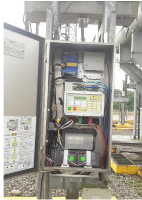
Figura 72 Tarjeta IOEX en RCT Laguna 03
