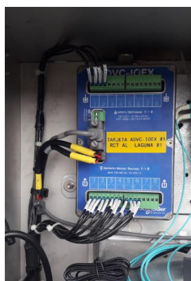
Figura 70 Tarjeta IOEX en RCT Laguna 01
