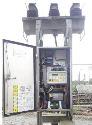
Figura 71 Tarjeta IOEX en RCT de Laguna 02
