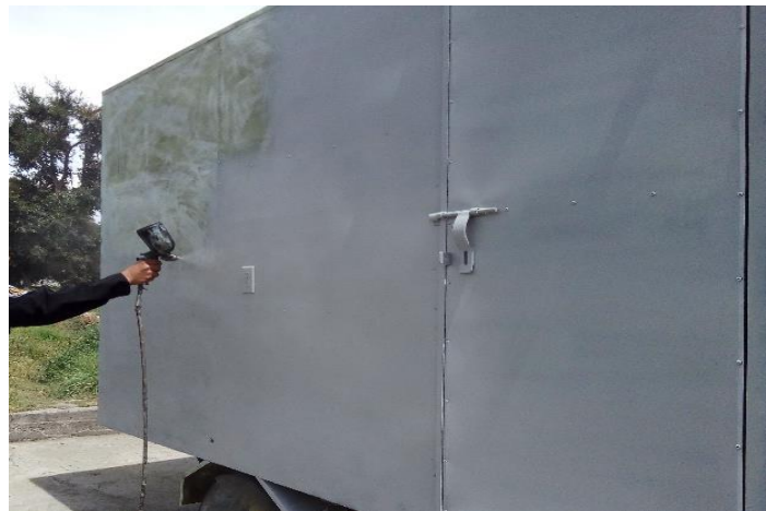
Figura 49 Mano de pintura con fondo gris laca.
