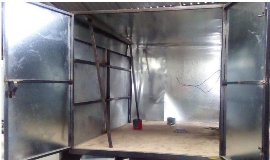
Figura 46 Furgón con el forro externo e instalando el interno.
