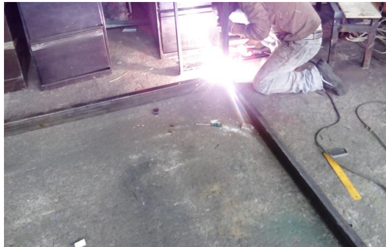
Figura 43 Montaje de la estructura.
