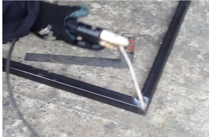
Figura 41 Fijación mediante suelda SMAW.
