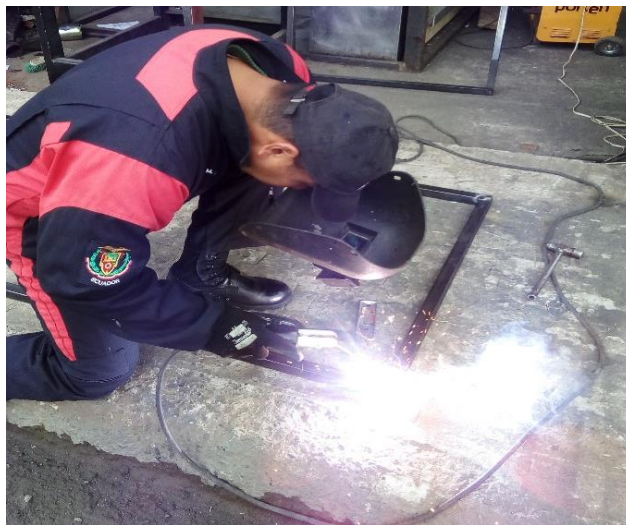
Figura 42 Proceso de Suelda SMAW.
