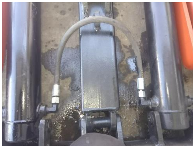
Figura 34. Instalación de la manguera hidráulica que une los cilindros
