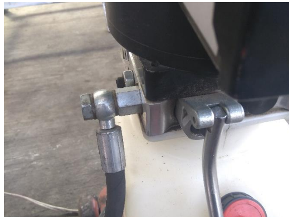
Figura 36. Instalación de la manguera que sale desde la unidad de potencia
