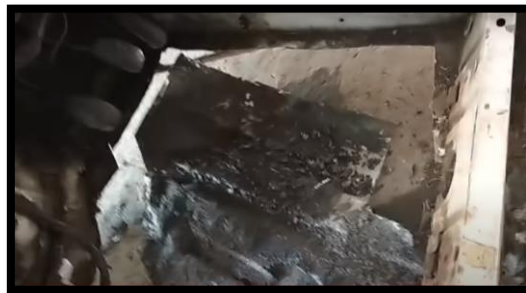
Figura 35. Corte Total Del Piso Podrido
