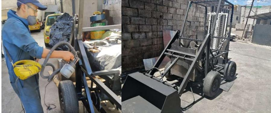
*Nota.* La pintura anticorrosiva se preparó con un cierta cantidad de tñer, para su aplicación se la realizo de manera simultánea y uniforme sobre la estructura.
