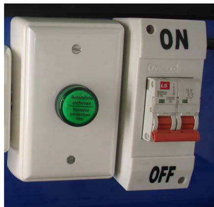
Foto. 3.14. Instalación de la luz piloto
