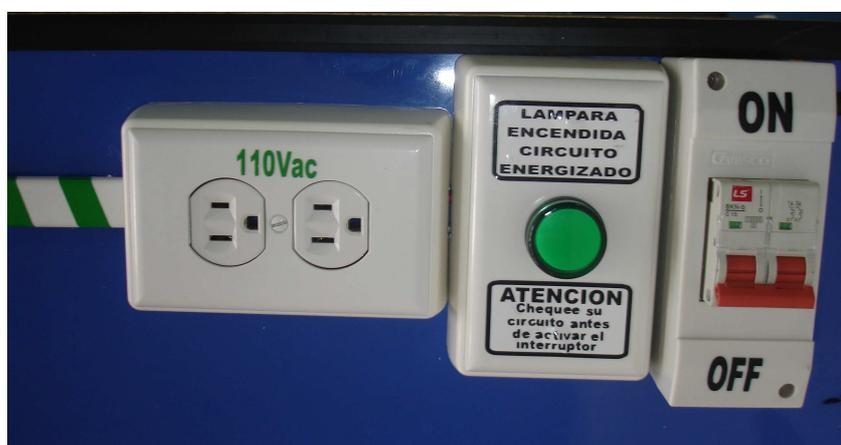
Foto. 3.17. Colocación de señalética el las instalación eléctricas.
