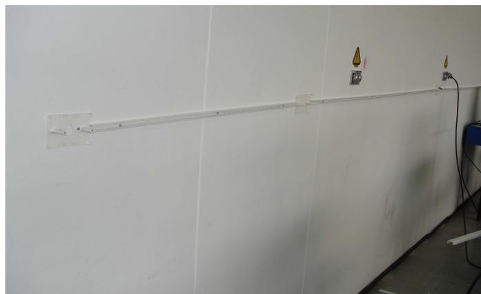
Foto. 3.9. Instalación de las canaletas y cajetines en las paredes
