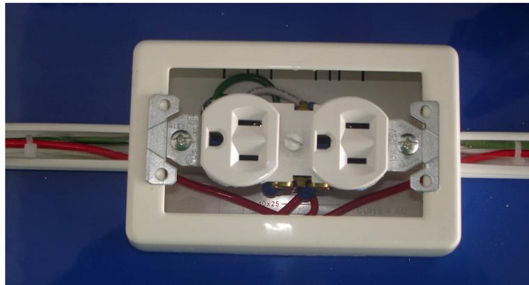
Foto. 3.15. Instalación de los tomacorrientes con los terminales
