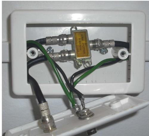
Foto. 3.20. Instalación del splitter de 2 vías
