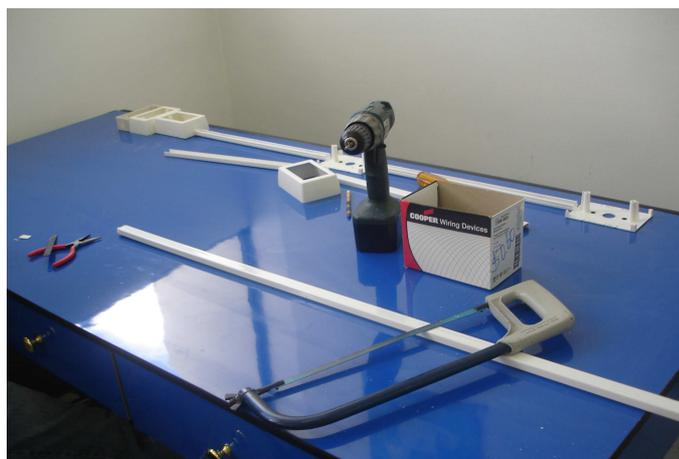
Foto. 3.12. Instalación de canaletas y cajetines sobrepuestos en las mesas
