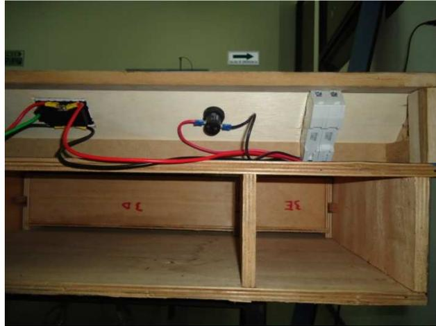
Foto 3. 20 Colocación del arnés en el tomacorriente 1 y conexión a luz piloto y breaker
