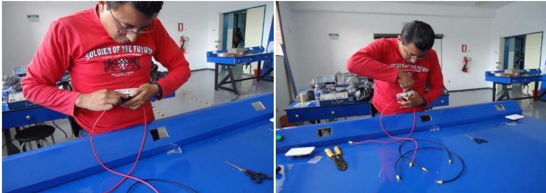
Foto 3. 15 Colocación y ajuste del cable de color rojo (Fase)
