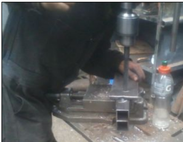
Figura 53: Perforación del tubo estructural
