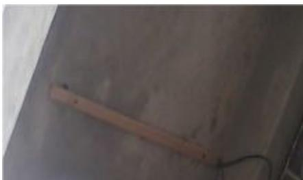
**Figura 64.-** Canaleta Adherida a la Pared.
