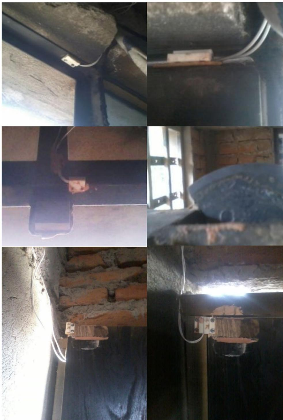
**Figura 83.-** Instalación de los Tres Sensores
