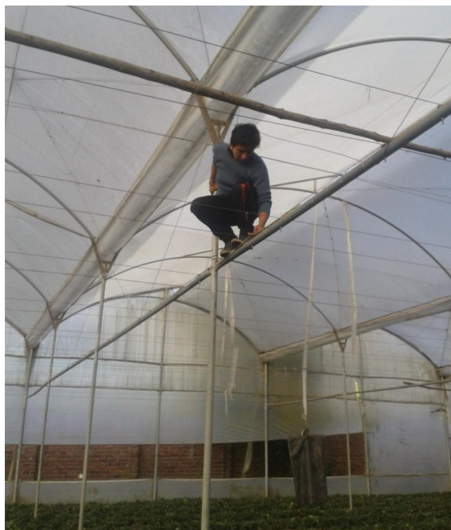
Figura 62. Cableado del tomacorriente parte superior del invernadero.
