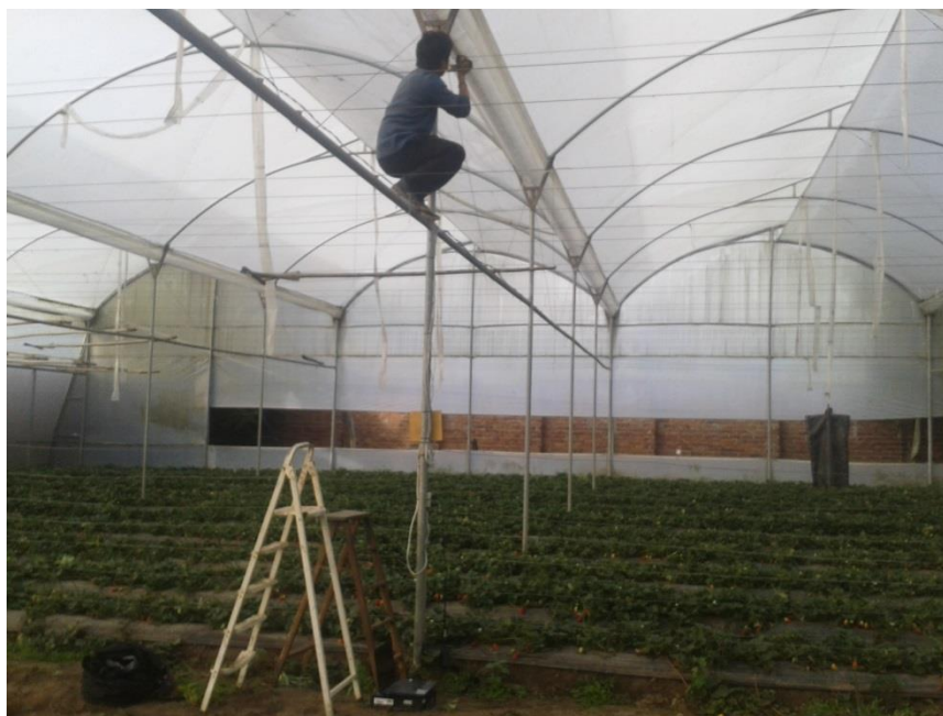
Figura 65. Instalación del cableado para los sensores DHT22.
