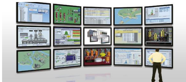
Figura 9 GE HMI SCADA iFIX PROFICY V 5.9
